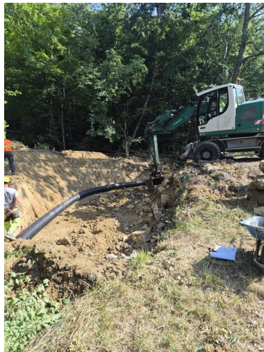
Le chantier du pont du Bédât
